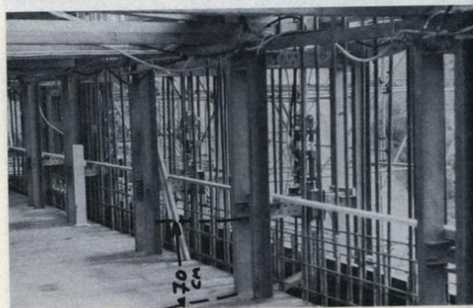
Vue de la plate-forme de bétonnage (plate-forme inférieure) du coffrage 24 van beton (het onderste platform) van de glijdende bekisting.
