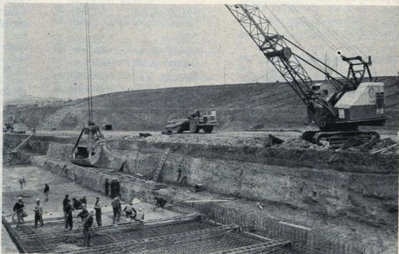
Bétonnage du radier d'une des deux trémies de chemin de roulement (pente 5%).
