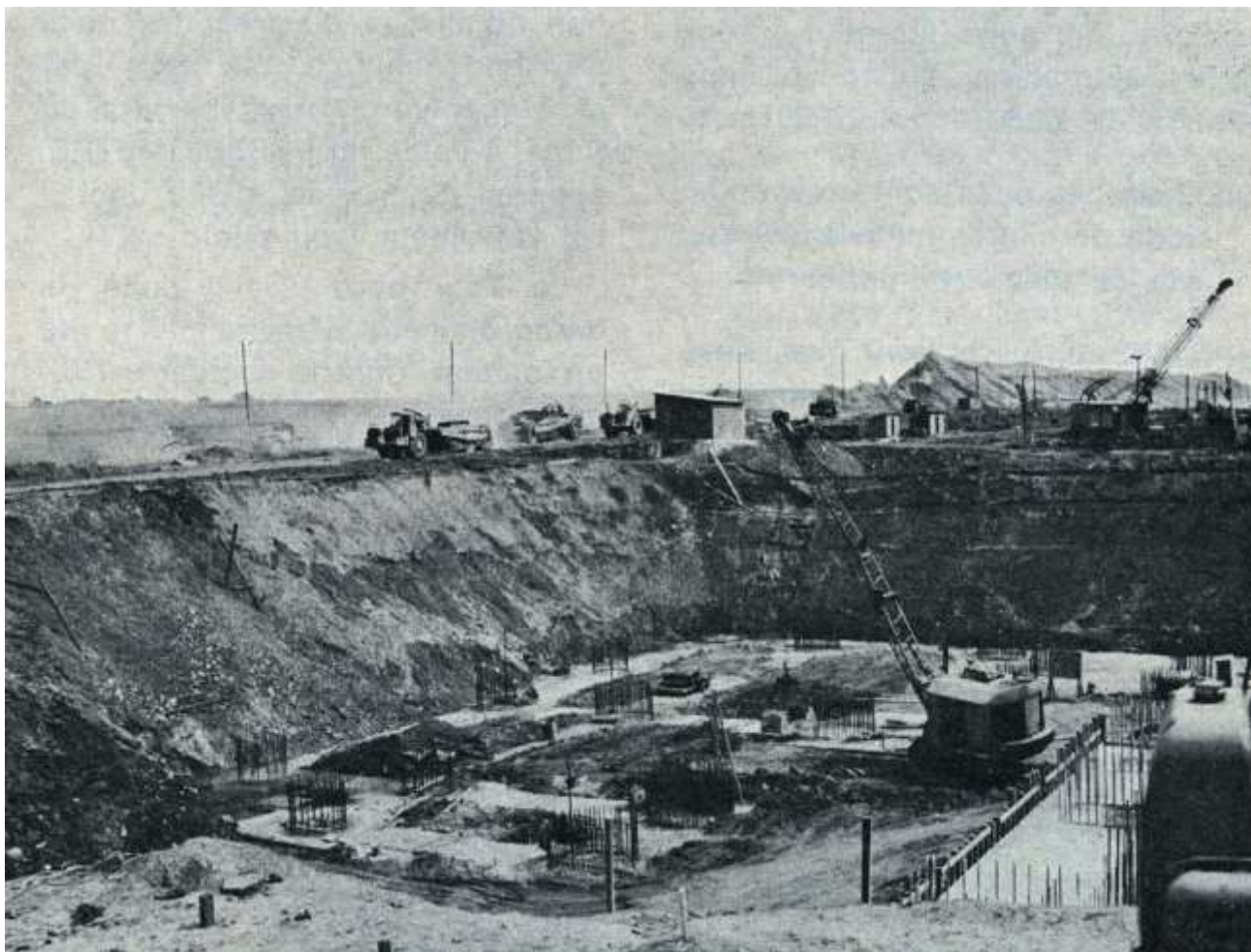
Figure 8: Une grue à grappin dans la fondation de la tête amont. Les têtes des puits de fondation sont clairement visibles. La couche de béton de propreté n'a pas encore été coulée.
