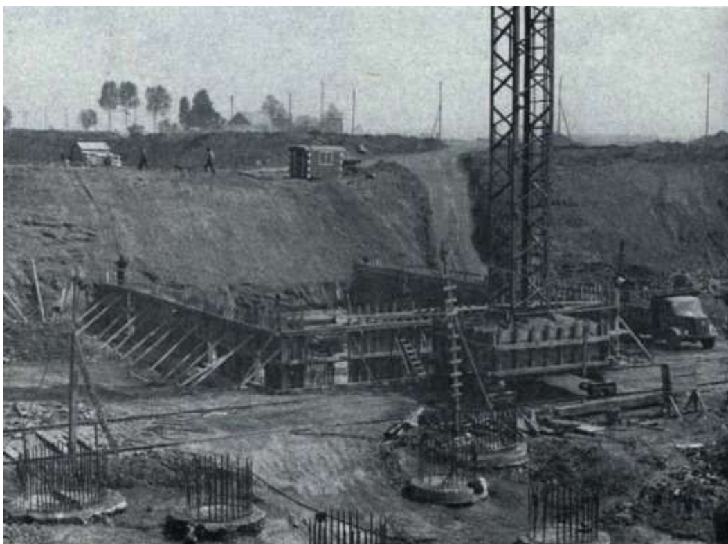
Figure 13: Mise en place du coffrage de la semelle de la tour au moyen d'une grue tour
