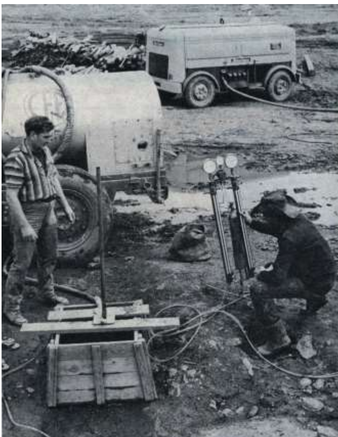
Figure 3: Tout le terrain situé sous la tête amont a fait l'objet d'une prospection minutieuse ayant pour but de déterminer les caractéristiques à donner aux puits des supports en béton.
