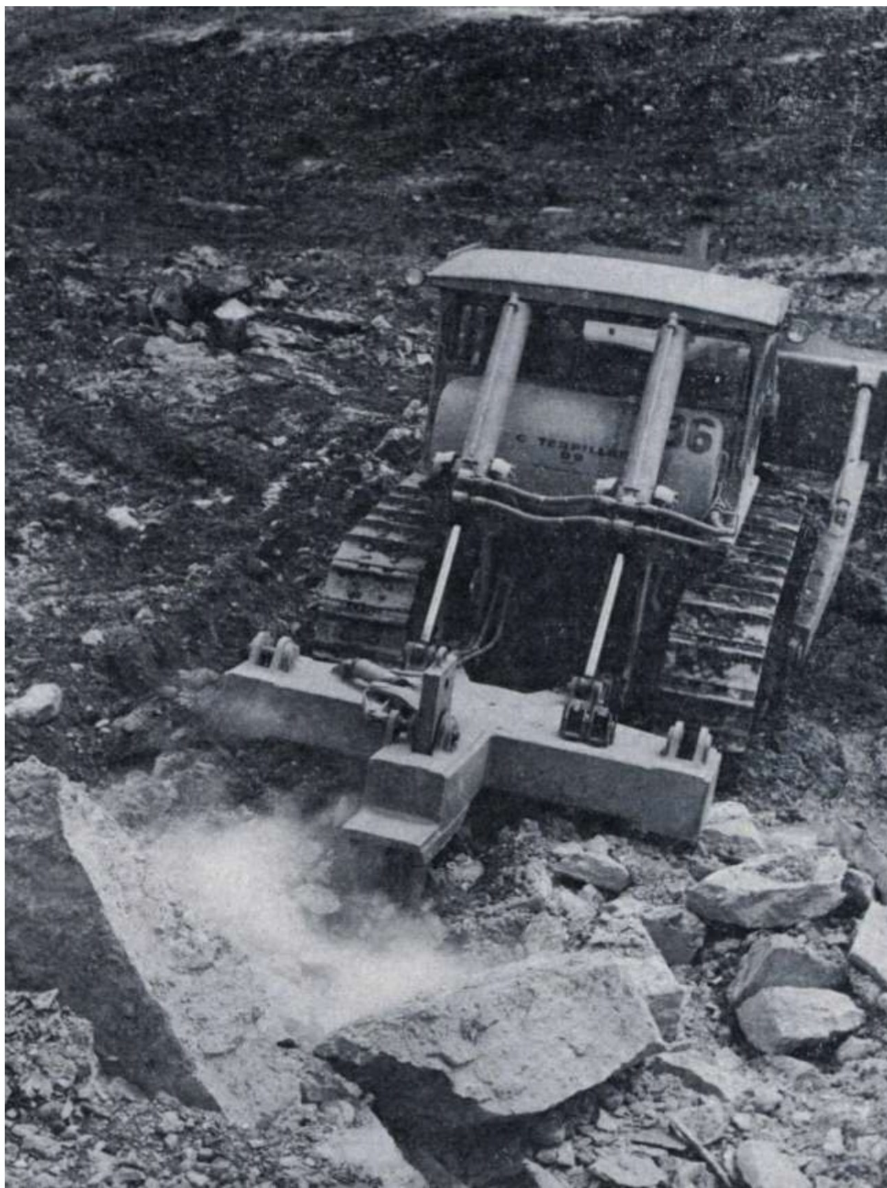
Figure 5: Un bulldozer a scarifié la roche dans les fondations de la tête amont soit directement soit après des tris d'ébranlement
