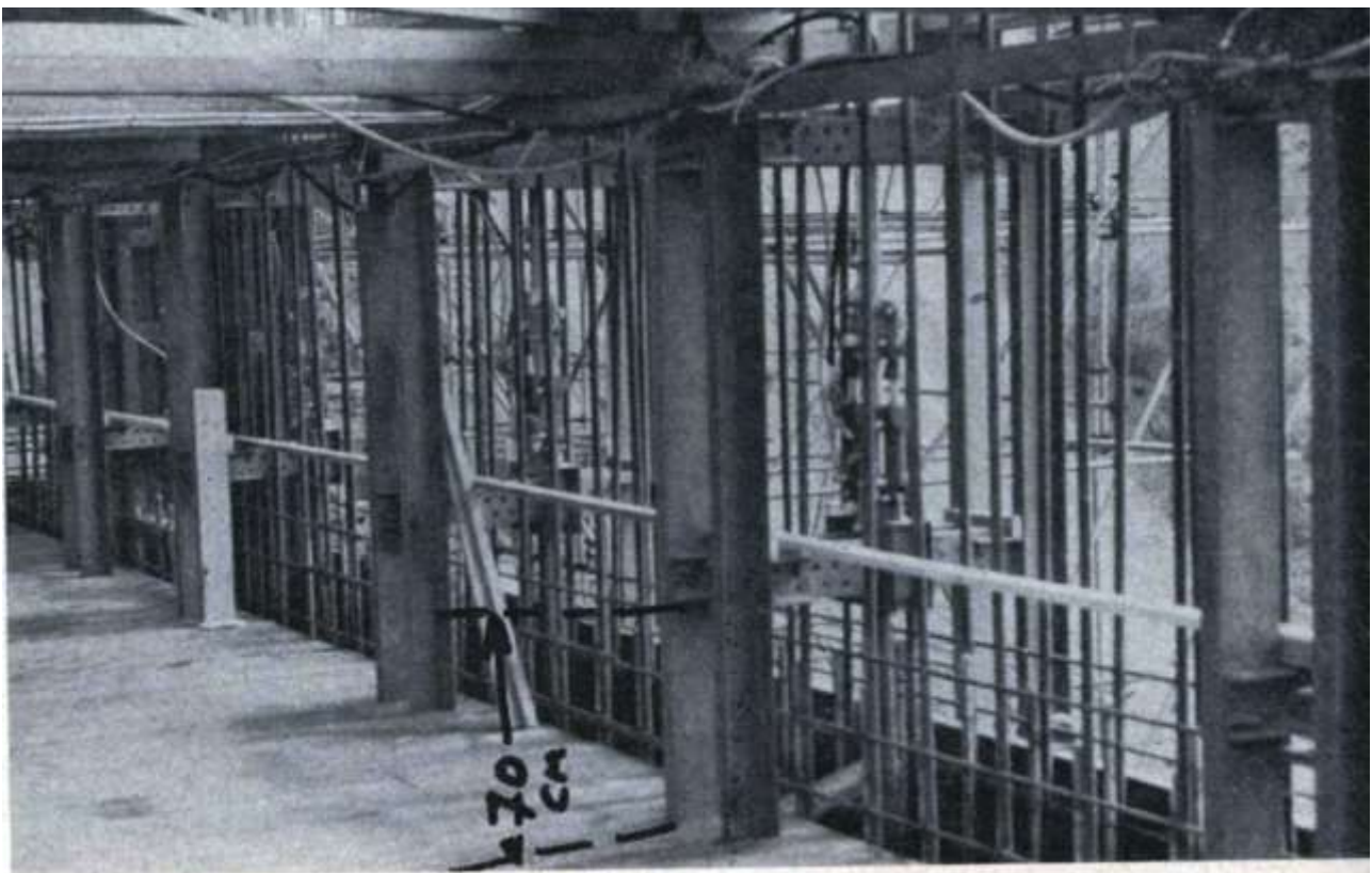
Figure 15: Vue de la plateforme de bétonnage intérieure du coffrage glissant
