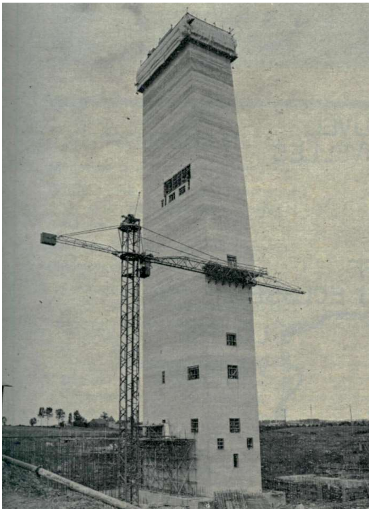
Figure 25: Vue de la tour depuis le Sud durant le mois d'août 1963
