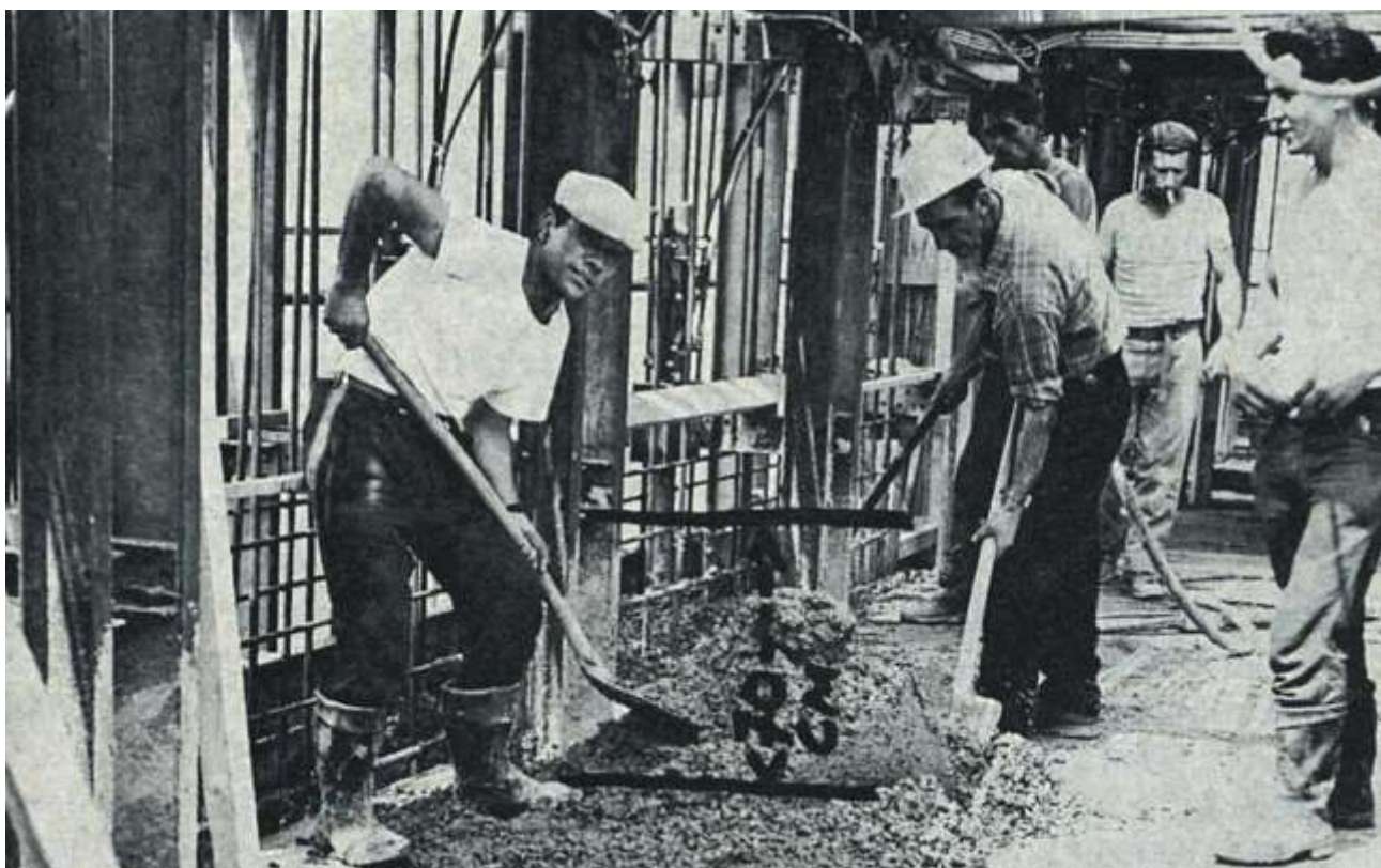
Figure 16: Il est intéressant de remarquer sur cette photo la position de travail des maçons qui peuvent travailler tout à fait normalement.
