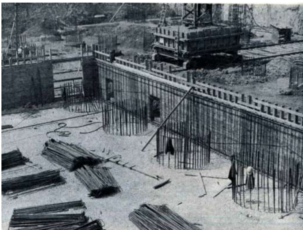
Figure 12: Sommet de quatre des huit puits de la semelle de la tour.
