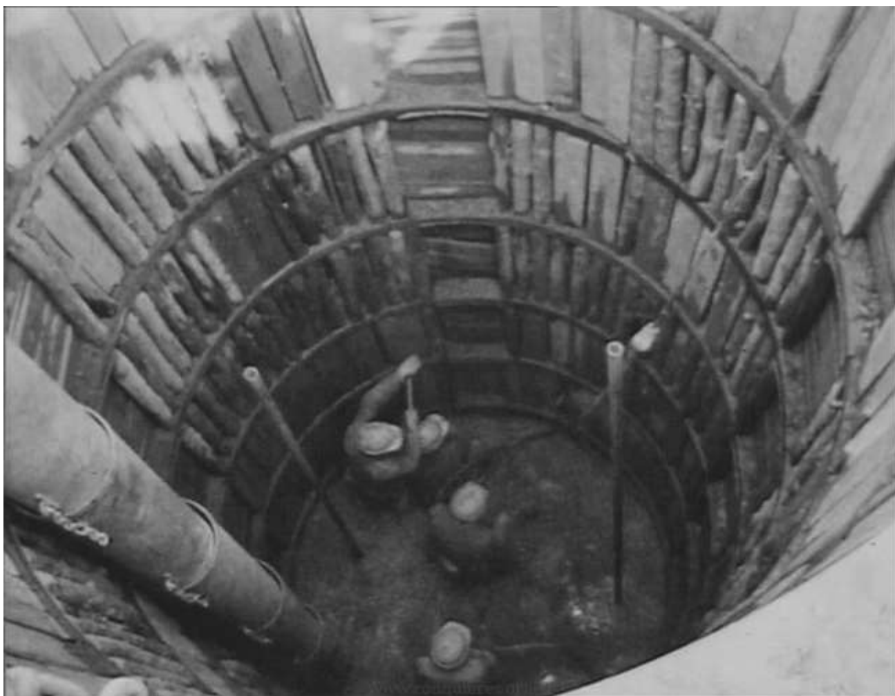
Figure 11: Mise en place du béton à l'intérieur d'un puit de fondation
