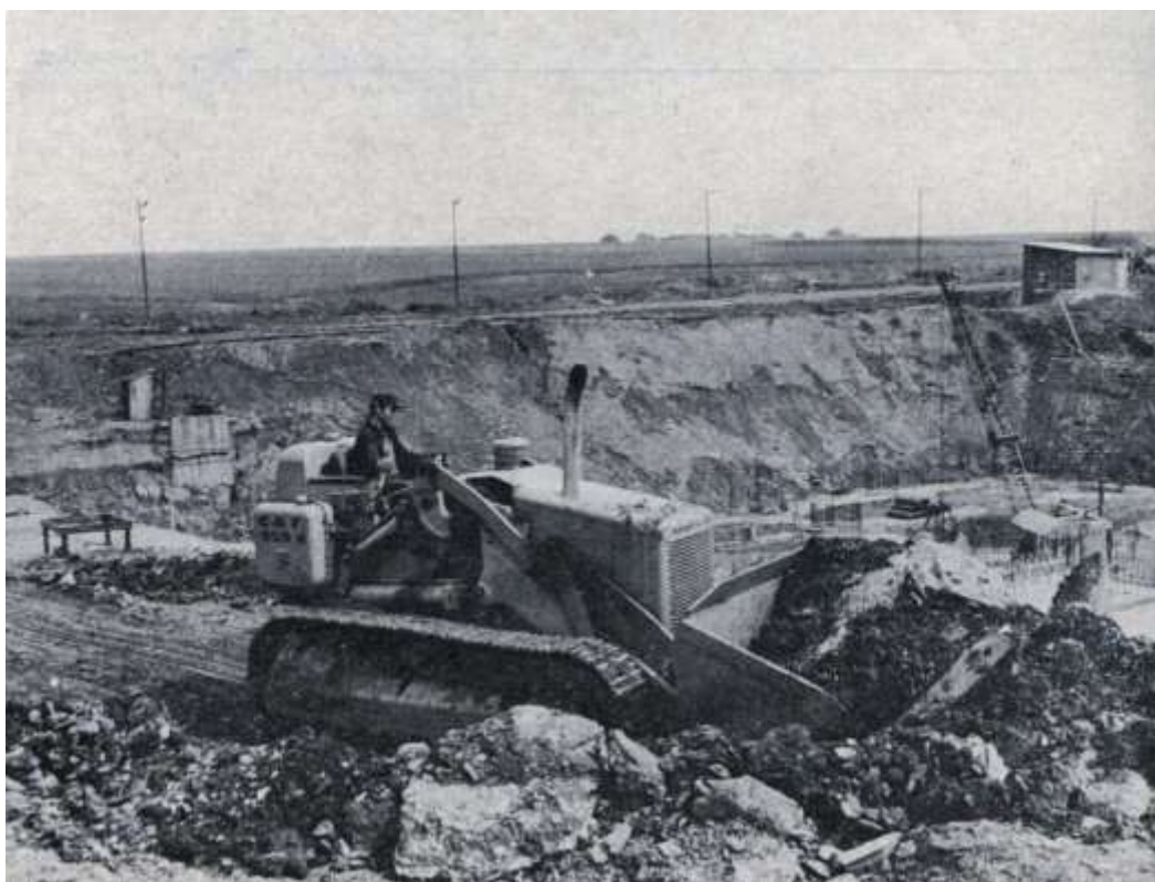
Figure 6: Un bulldozer occupé aux travaux de terrassement dans le secteur de la tête amont
