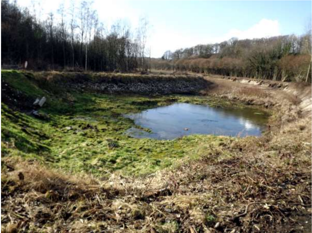
Figure 16 : L'extrémité de l'ancien bief 29 du côté « Charleroi ». Il ne reste plus qu'une modeste flaque d'eau...
