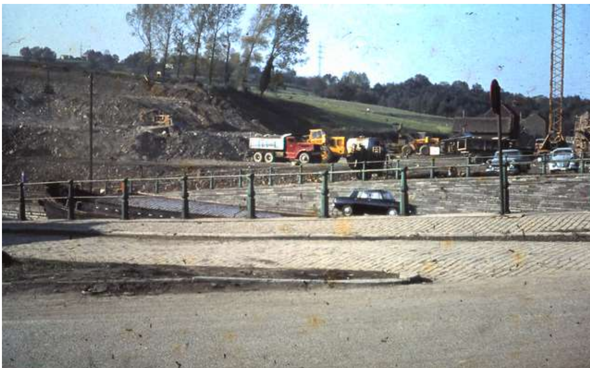
Figure 13 : La présence de ce chantier pharaonique n'a aucunement affecté le trafic sur l'ancien canal comme en témoigne cette péniche qui passe sous l'ancien pont d'Asquimpont.
