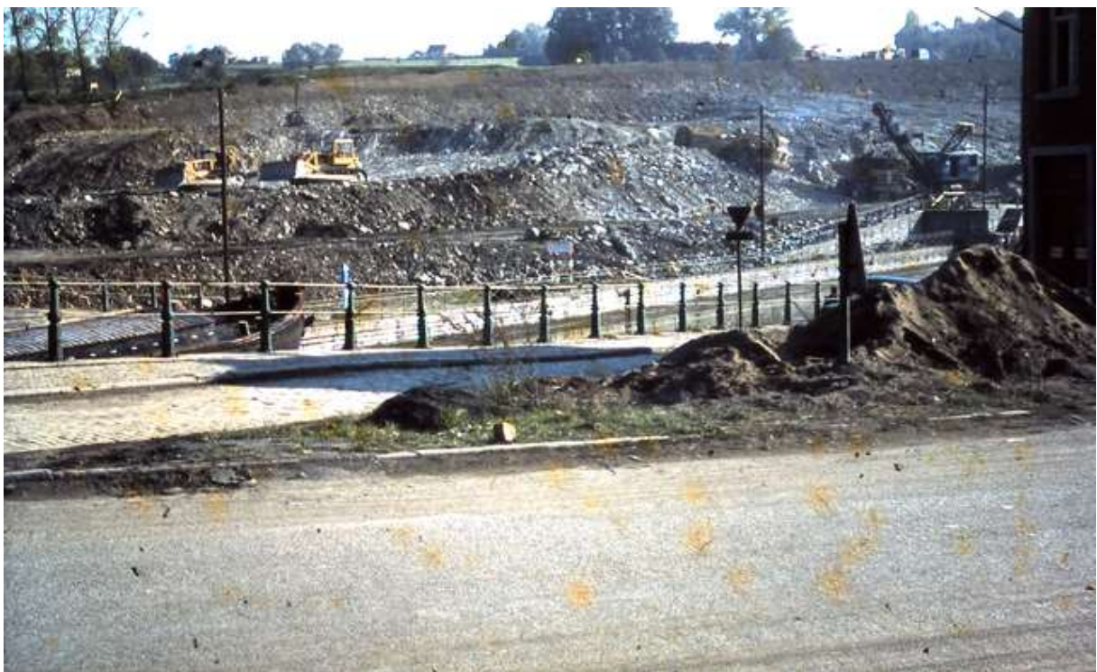
Figure 12 : Le début des terrassements de la colline en face des « Papeteries de Virginal »
