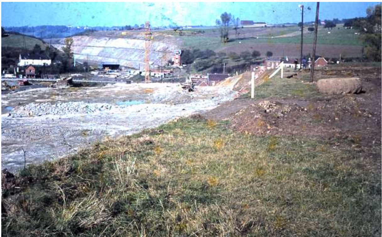
Figure 10 : Dans le fonds de l'image, la tranchée d'Ittre a été creusée en 5 couches successives.
