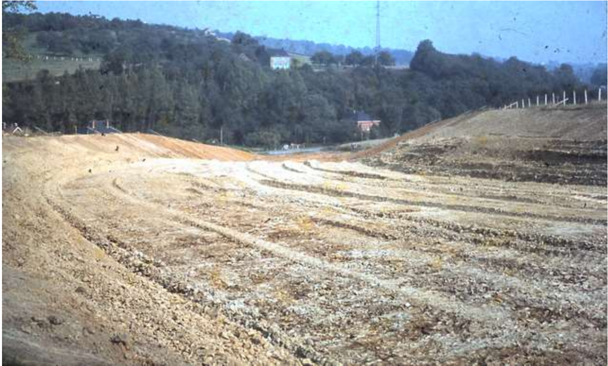
Figure 9 : La colline d'Asquimpont avant qu'elle ne soit enlevée. Ce cliché nous éclaire aussi sur la méthode d'excavation utilisée que certains appellent en épluchure d'oignons : la tranchée fut creusée, comme à Ronquières en plusieurs couches successives qui permirent de déplacer finalement près de 3.5 millions de mètres cubes de roches diverses.
